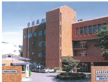
解体前の南校舎
