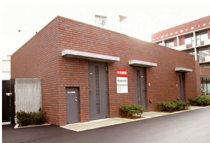
②危険物・廃溶剤庫
