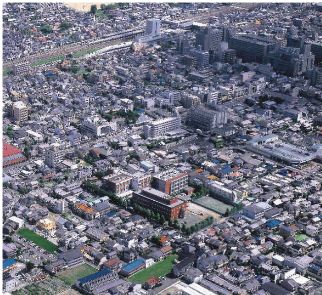
創薬科学フロンティア研究センター建設後の南校地一帯 (2009年度卒業アルバムから)
