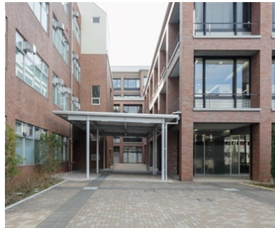
渡り廊下（躬行館-育心館）
